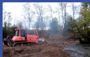
Travaux sur l'étang de Pont-du-Château
